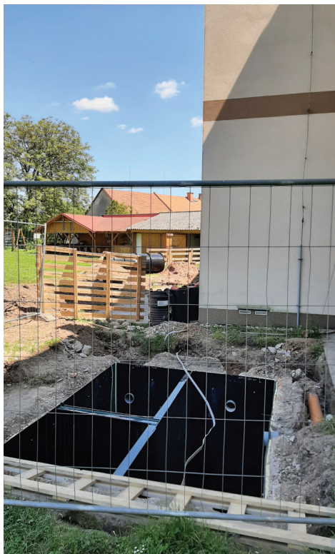
rekonstrukce septiku v ZŠ
